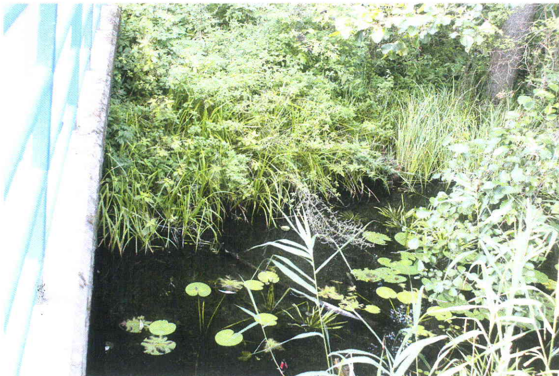
Fot. 8 Zanieczyszczenie koryta cieku oraz wegetacja roślinności na stożkach nasypów
