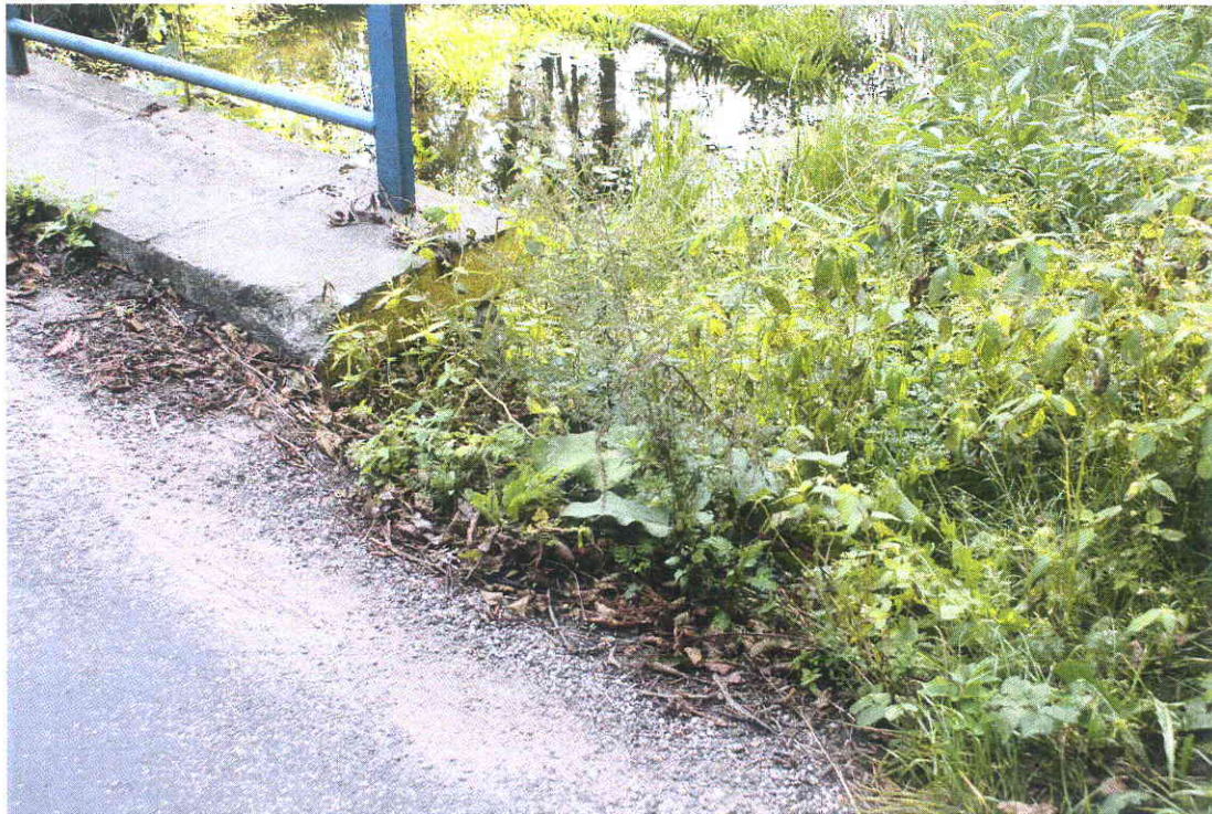
Fot. 7 Ubytki betonu w belkach podporęczowych oraz wegetacja roślinności na poboczach
