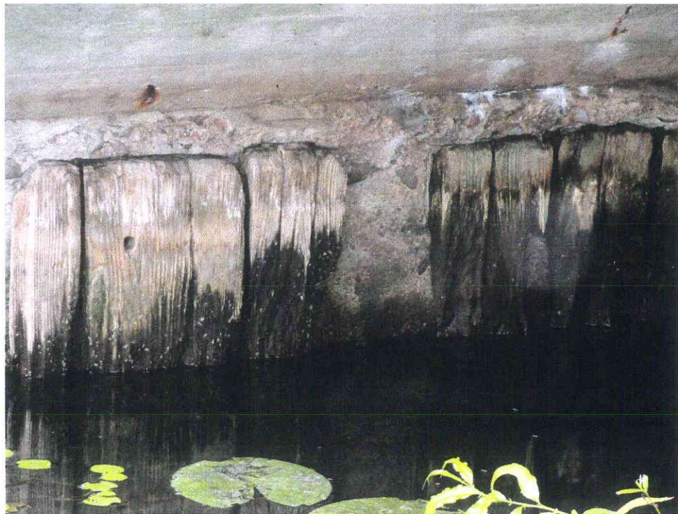
Fot. 3 Ubytki drewnianej ścianki szczelnej przyczółków
