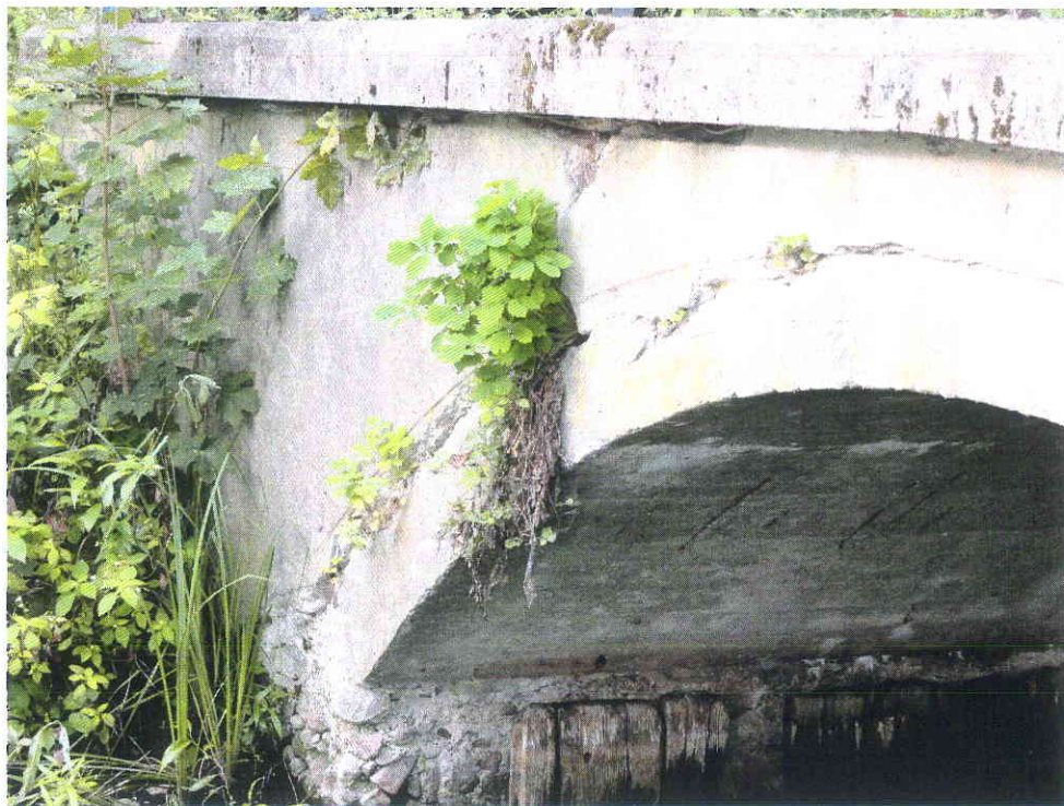
Fot. 5 Wegetacja roślinności oraz spękania ścian czołowych nadłucz
