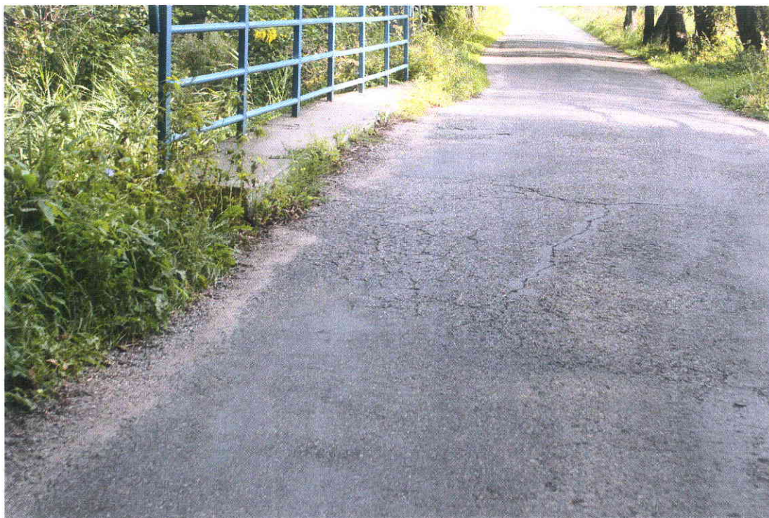
Fot. 6 Zapadnięcia oraz zarysowania nawierzchni bitumicznej na dojazdach
