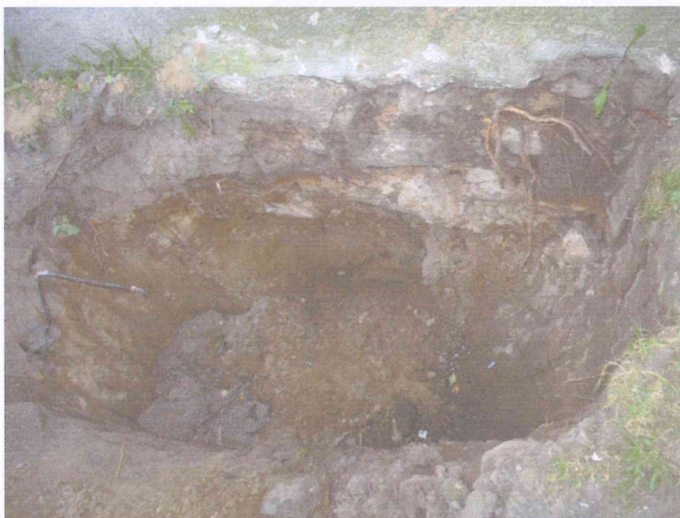
foto. 4. Odkrywka fundamentu F1
