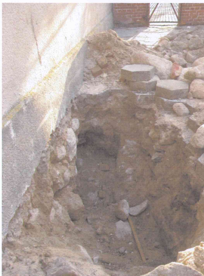
foto. 2. Odkrywka fundamentu F3
