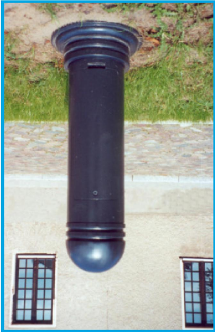
Słupek zaopatrzeniowy ( poboru energii ) typu TVP-3000 f-my "TRAPP-GmbH" Sp. z o.o.
