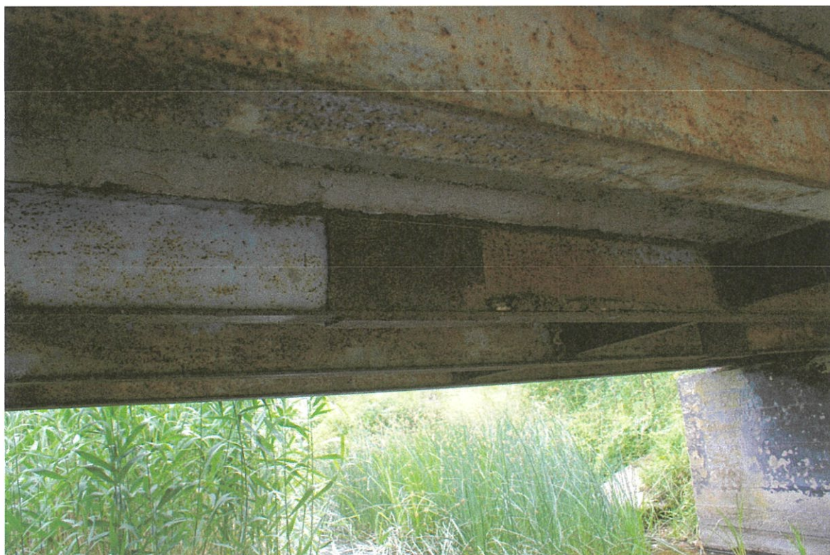
Fot. 7 Korozja dźwigarów głównych z dwuteownika 300.
