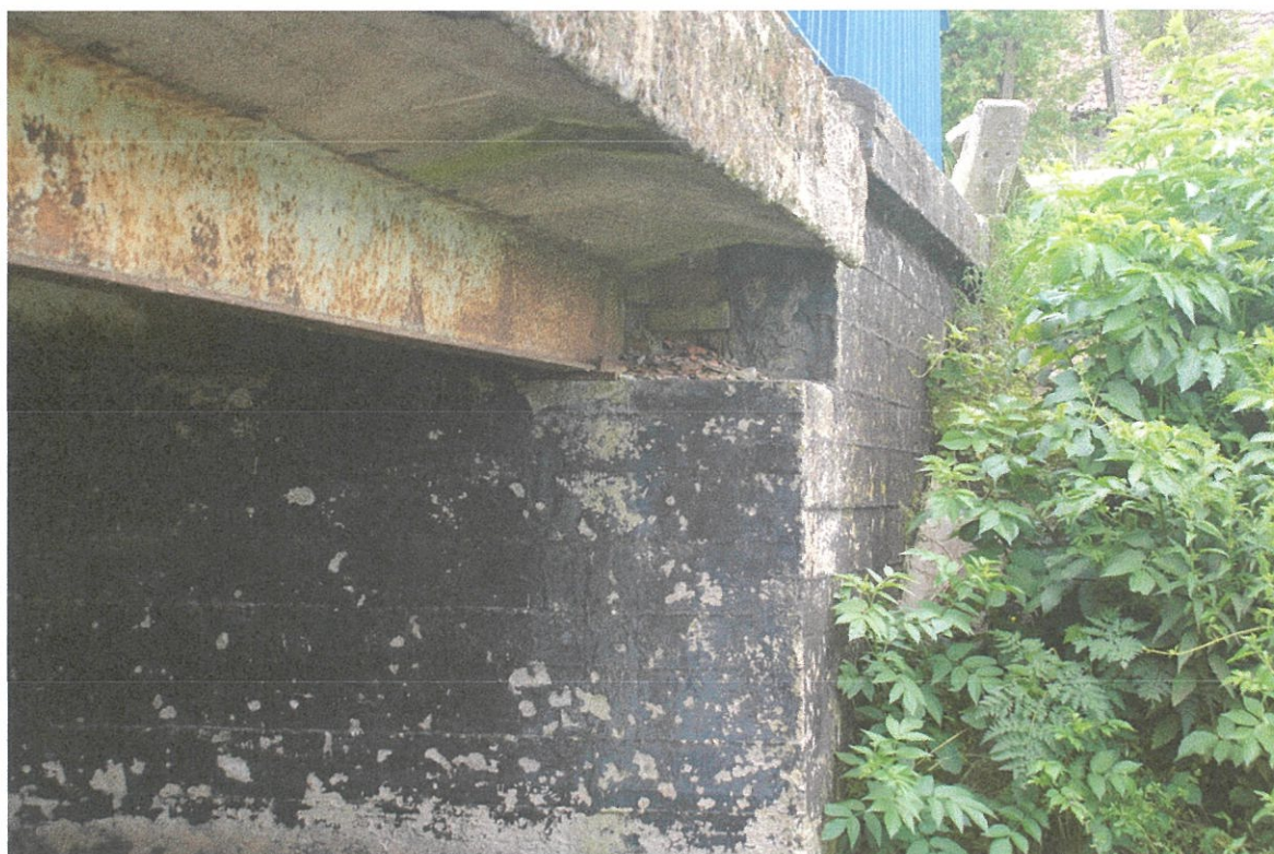
Fot. 5 Wegetacja roślinności na stożkach i zanieczyszczenie ciosów podłożyskowych.
