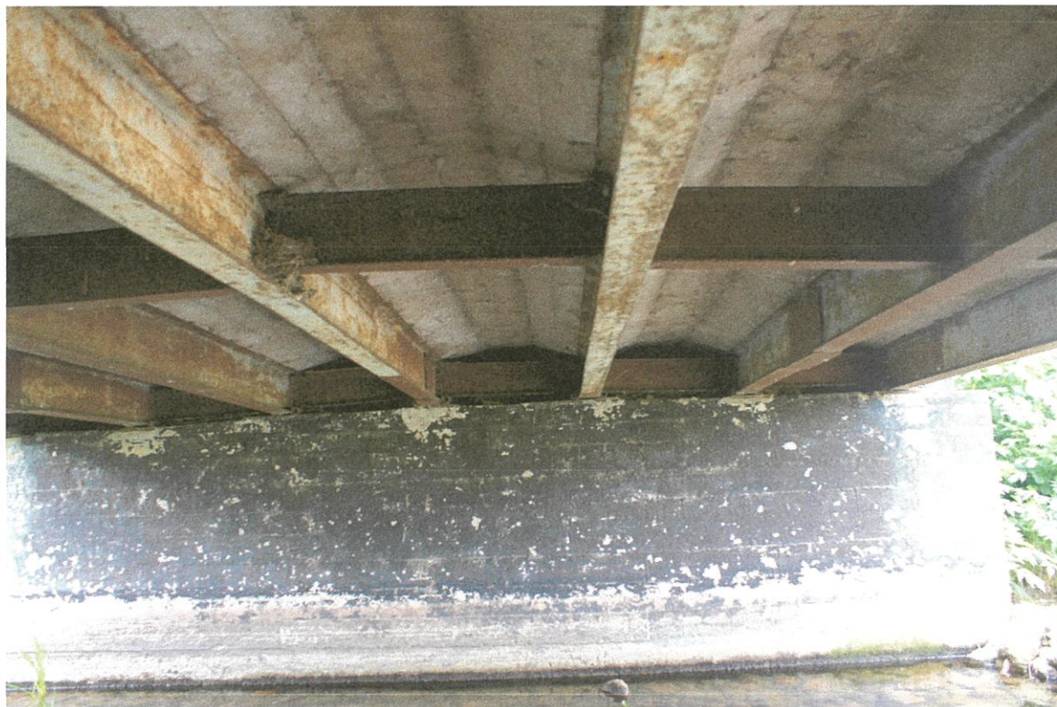
Fot. 4 Stan dźwigarów stalowych i żelbetowej płyty pomostu oraz przyczółka
