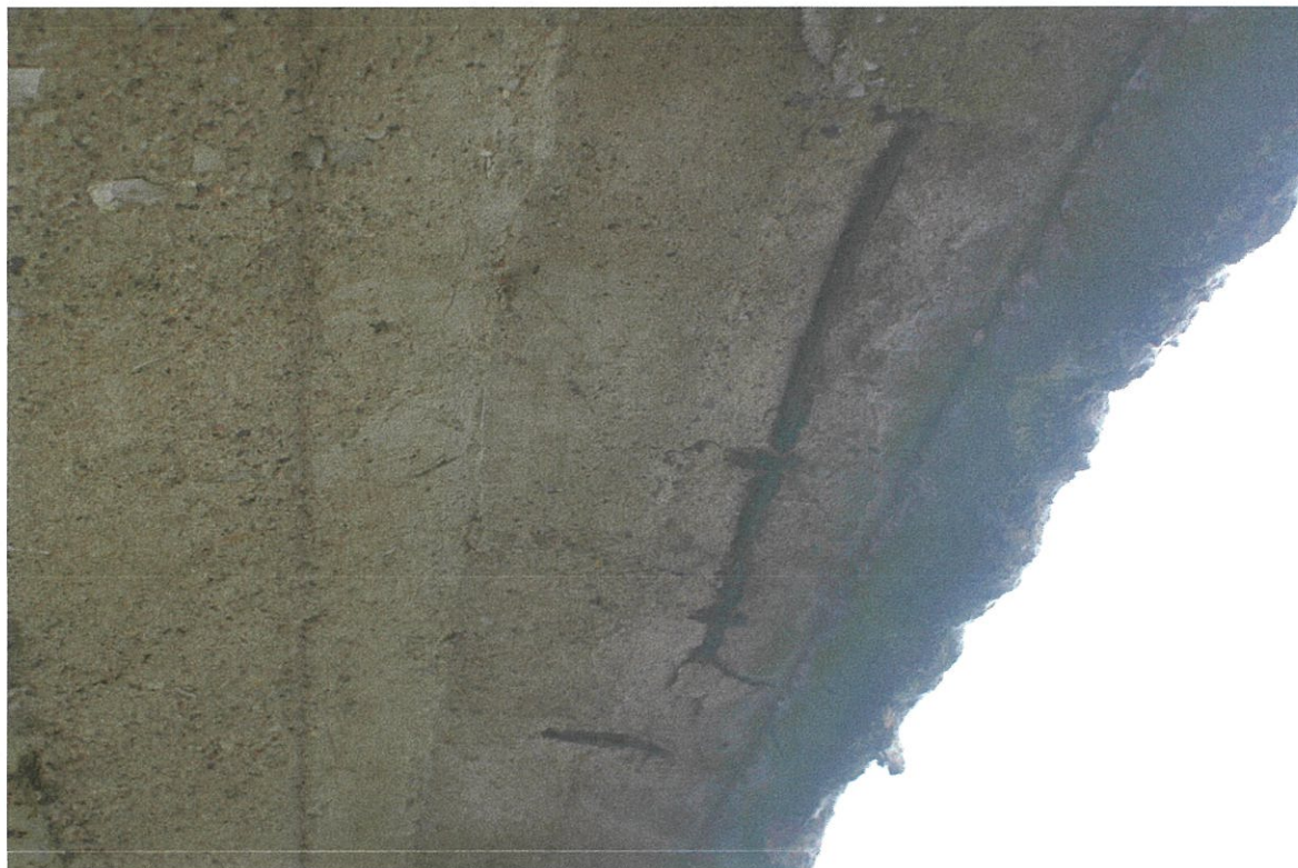
Fot. 6 Brak otuliny i korozja zbrojenia od spodu gzymsu.
