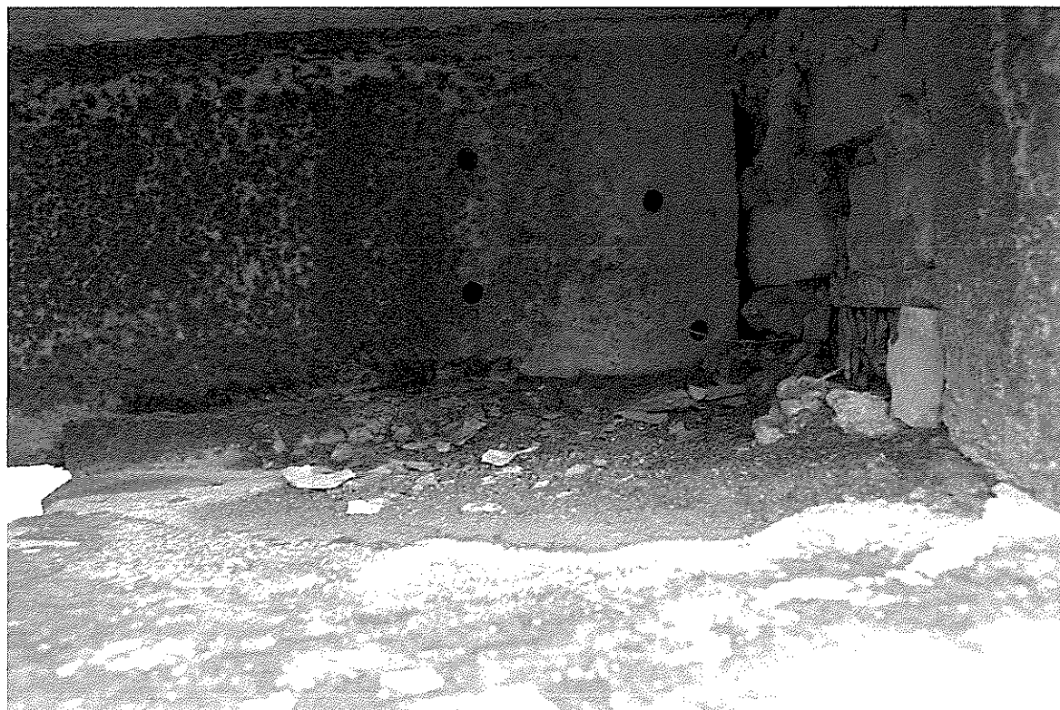
Fot. 8 Korozja dźwigara, łożyska oraz zanieczyszczenie ciosów podłożyskowych.
