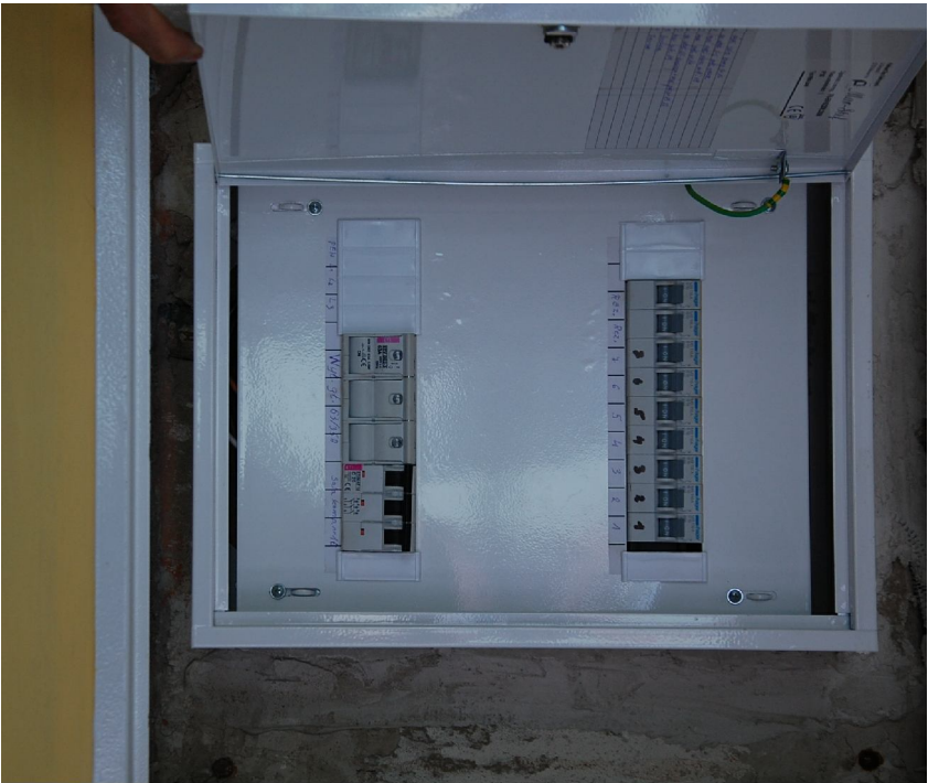
Projektowana rozdzielnia piętrowa TP-2
