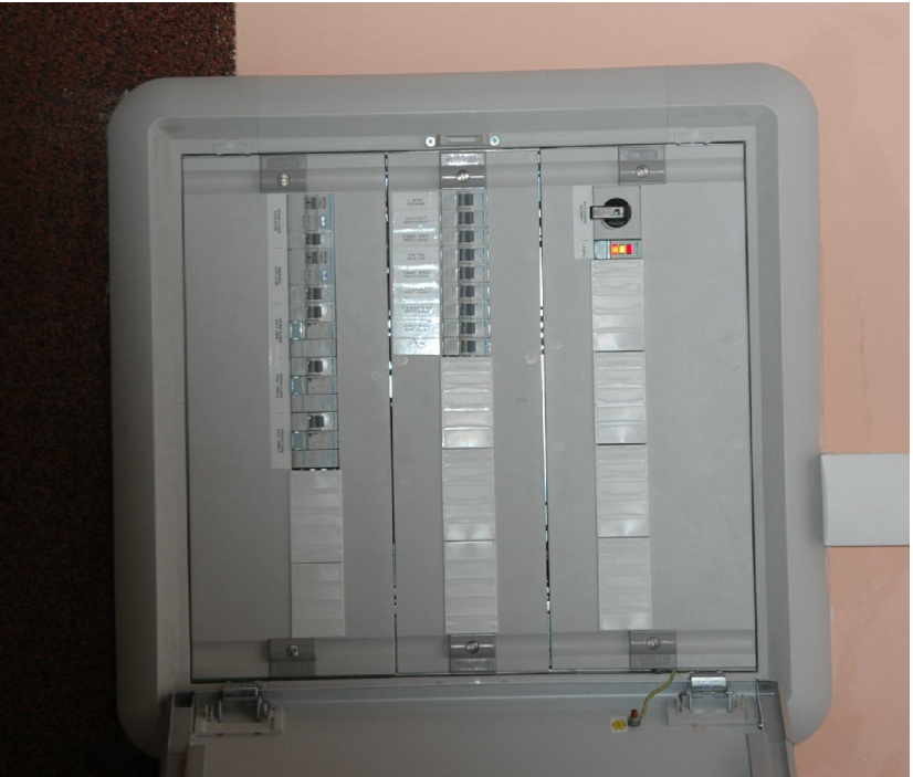
Istn. tablica TG-1 zasilana z ZK-1 / do przebudowy /
