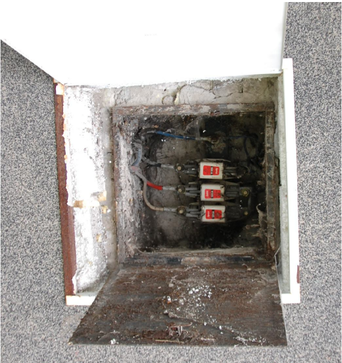
Istn. złącze ZK-1 na bud."D" ZSO w Piszu - brak uzziemienia
